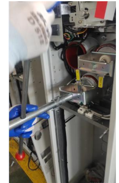
3.使用操作手柄逆时针 旋转打开熔断器盒
