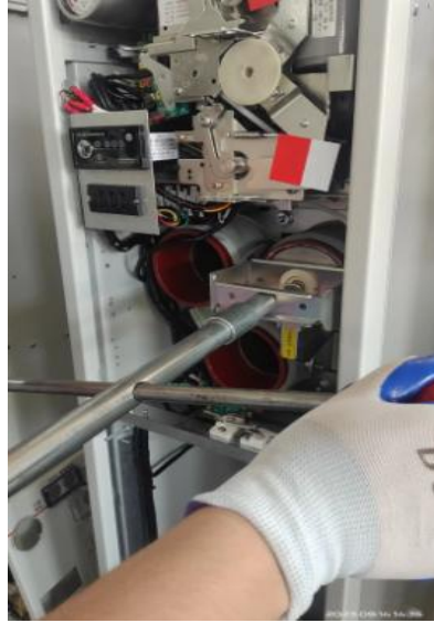
6.使用操作手柄顺时针旋转熔断器盒端盖上的手柄以闭合并密封熔断器盒
