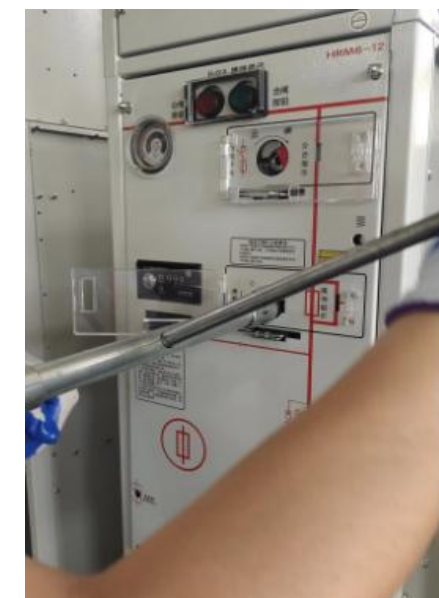
1.顺时针宣传操作手柄 闭合接地开关
