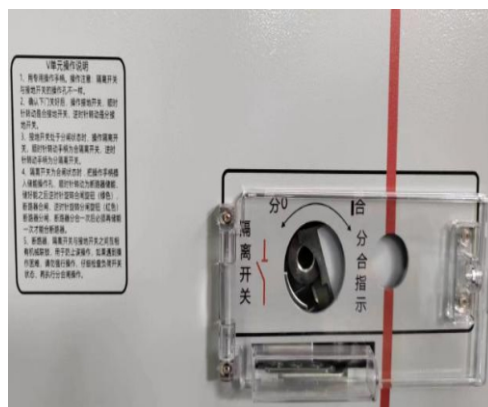
a.打开隔离操作孔 插入操作手柄
