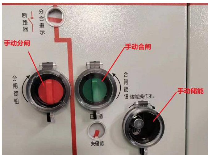
a.面板操作指示:面板上绿色旋钮合闸 面板上红色旋钮分闸
