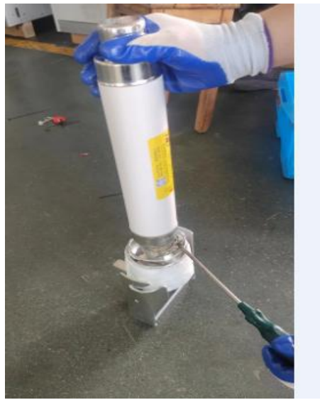
5.用紧固螺钉将熔断器紧固在熔断器盒端盖上,撞针必须指向外部
