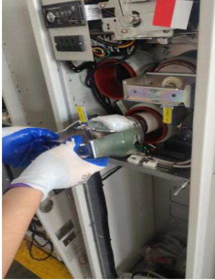
4.拉熔断器盒手柄(熔断器是被紧紧固定在熔断器盒端盖上)
